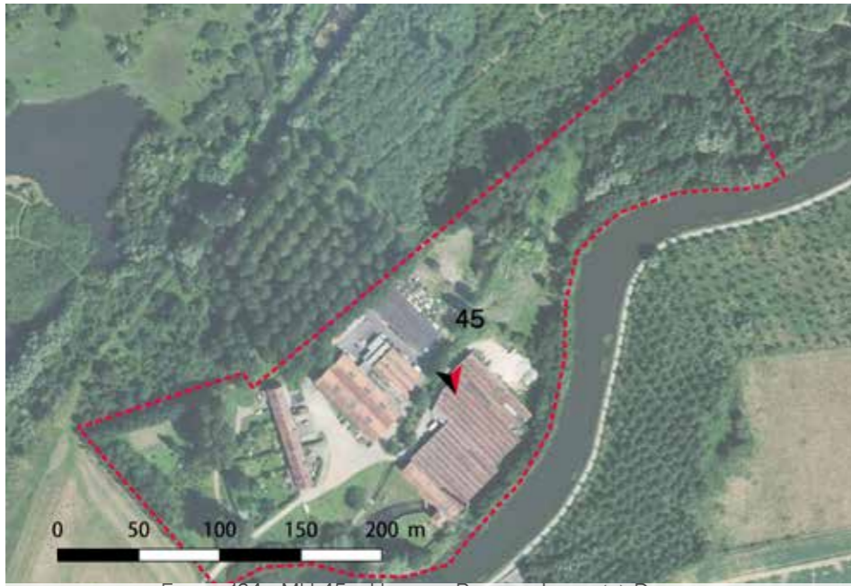
FIGURE 134 : MH 45 - USINE DU PARQUET LOUTRÉ A DAOURS
